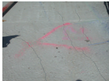
Esquerdes per falta de curat del formigó
